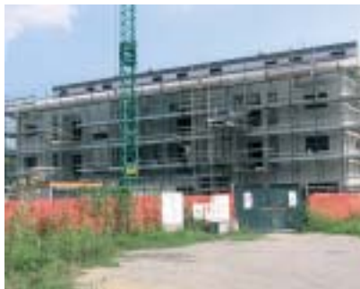
Cantiere per la costruzione di 10 alloggi Salgareda loc. Campodipietra
