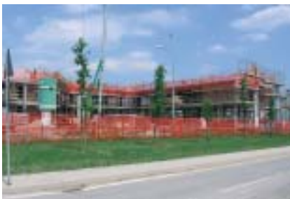
Cantiere per la costruzione di 14 alloggi-San Fior
