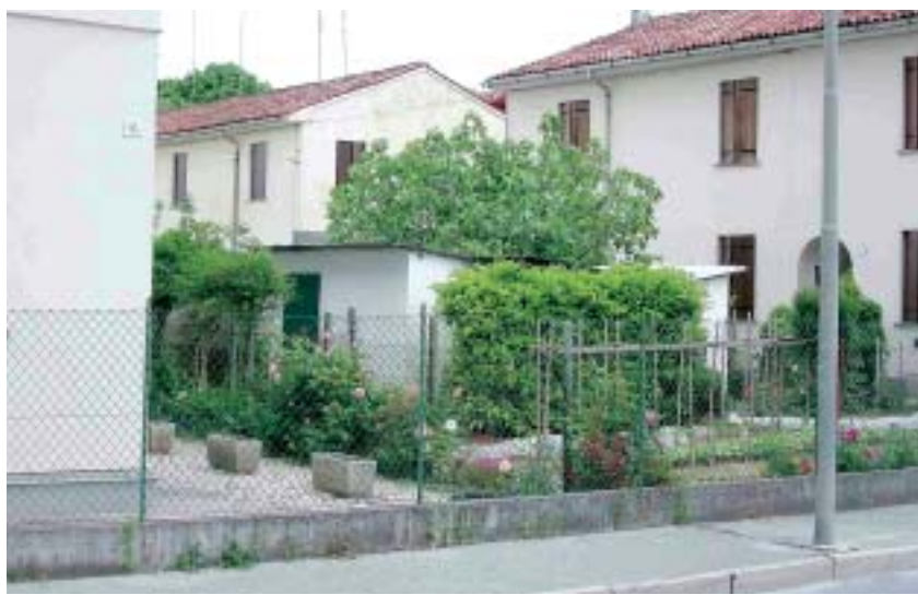
Alloggi a Motta di Livenza – Intervento di manutenzione straordinaria
