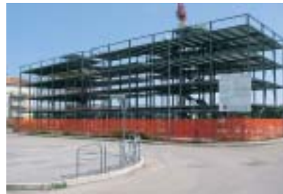
Cantiere per la costruzione di 27 alloggi - Treviso S. Bona Area PEEP
