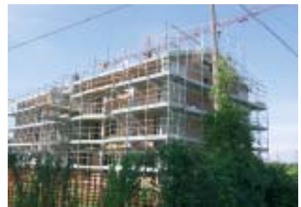
Cantiere per la costruzione di 6 alloggi S. Biagio - Fagarè
