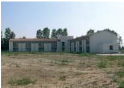
Cantiere per la costruzione di 15 mini alloggi per anziani - Vedelago
