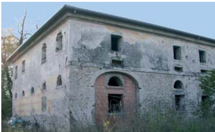
Arcade - barchessa di villa Cavalieri lavori di recupero in corso
