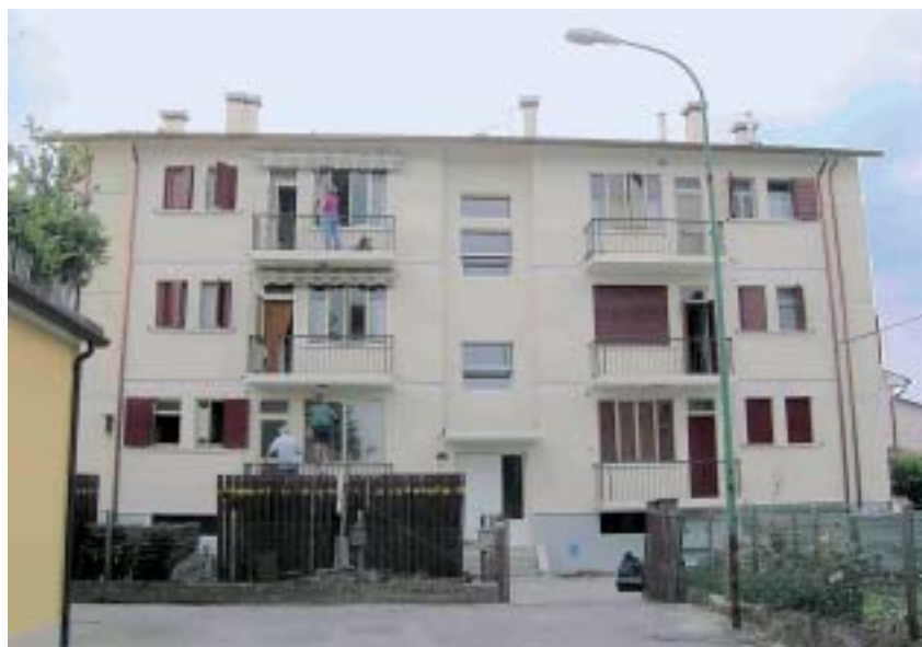
Intervento di manutenzione su un fabbricato in Monastier, viale Europa
