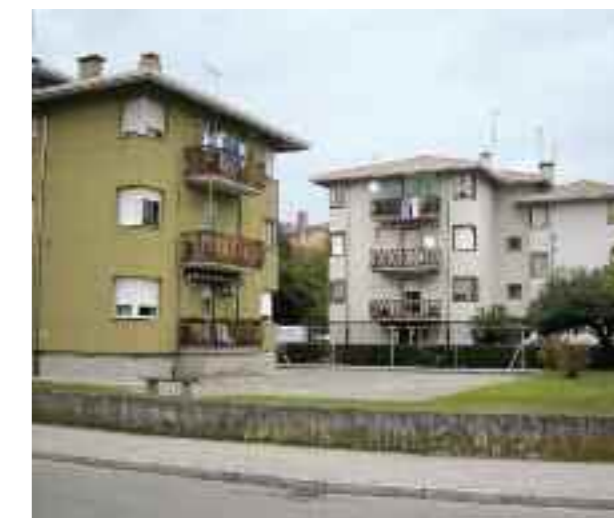
Nella foto sopra: vista di uno dei fabbricati di Treviso, viale Nazioni Unite
