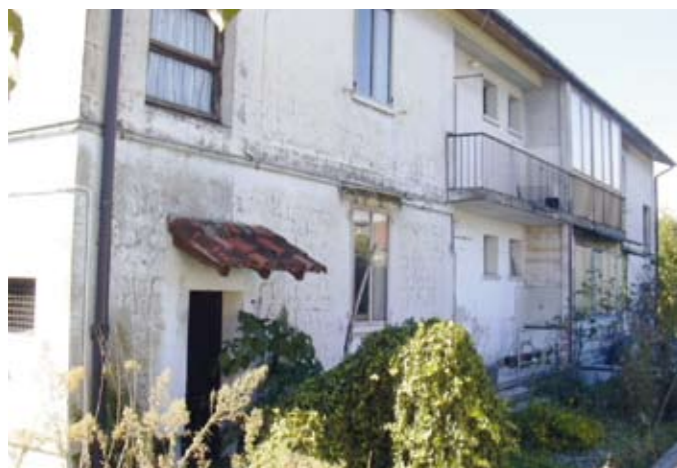
Foto sopra: il fabbricato prima dell'intervento.
