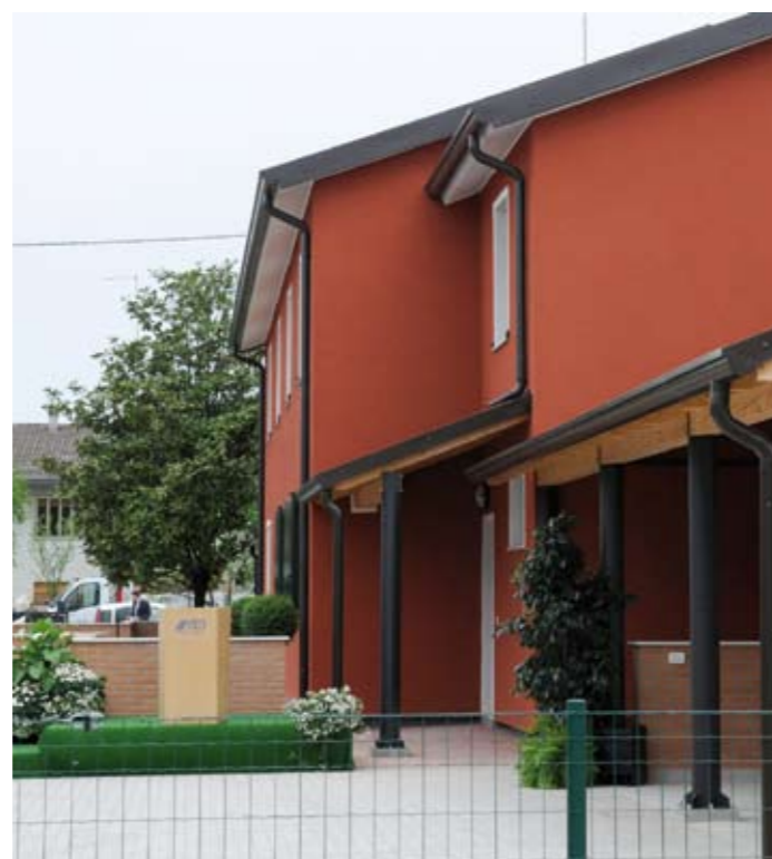
Nella foto: il fabbricato dopo l'intervento di recupero
